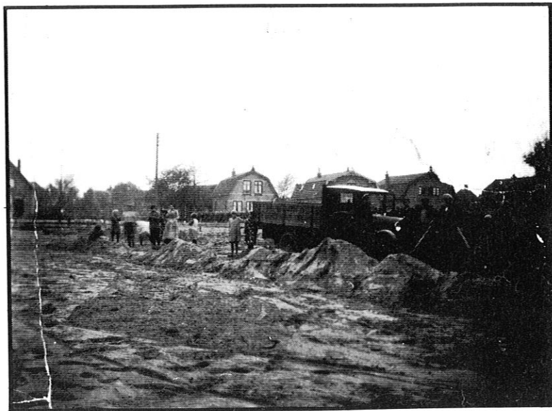
Voor de nieuwbouw van de woning en schuur aan de Straatweg werd eerst een grote partij zand gestort. De boerderij aan de Voort moest worden gesloopt voor de aanleg van een weg naar Bakkum. Op de achtergrond de Straatweg.
