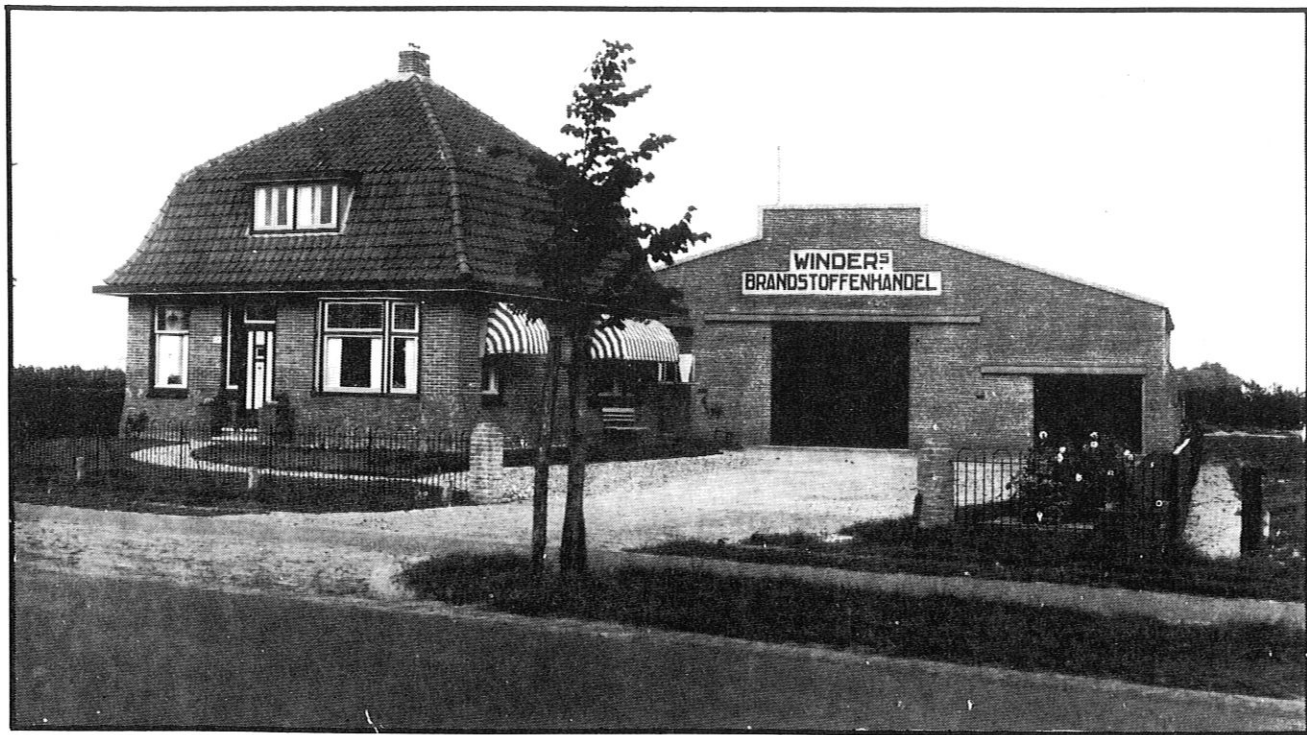
Het huis aan de Straatweg. Het fraaie smeedijzeren hek rond het erf is verdwenen. Verder is er weinig veranderd. De brandstofschoor is later vervangen door een grotere garage.
